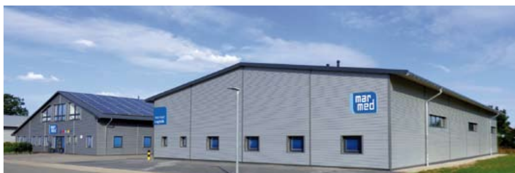
Fertigstellung und Inbetriebnahme der neuen Logistikhalle Mai 2018
